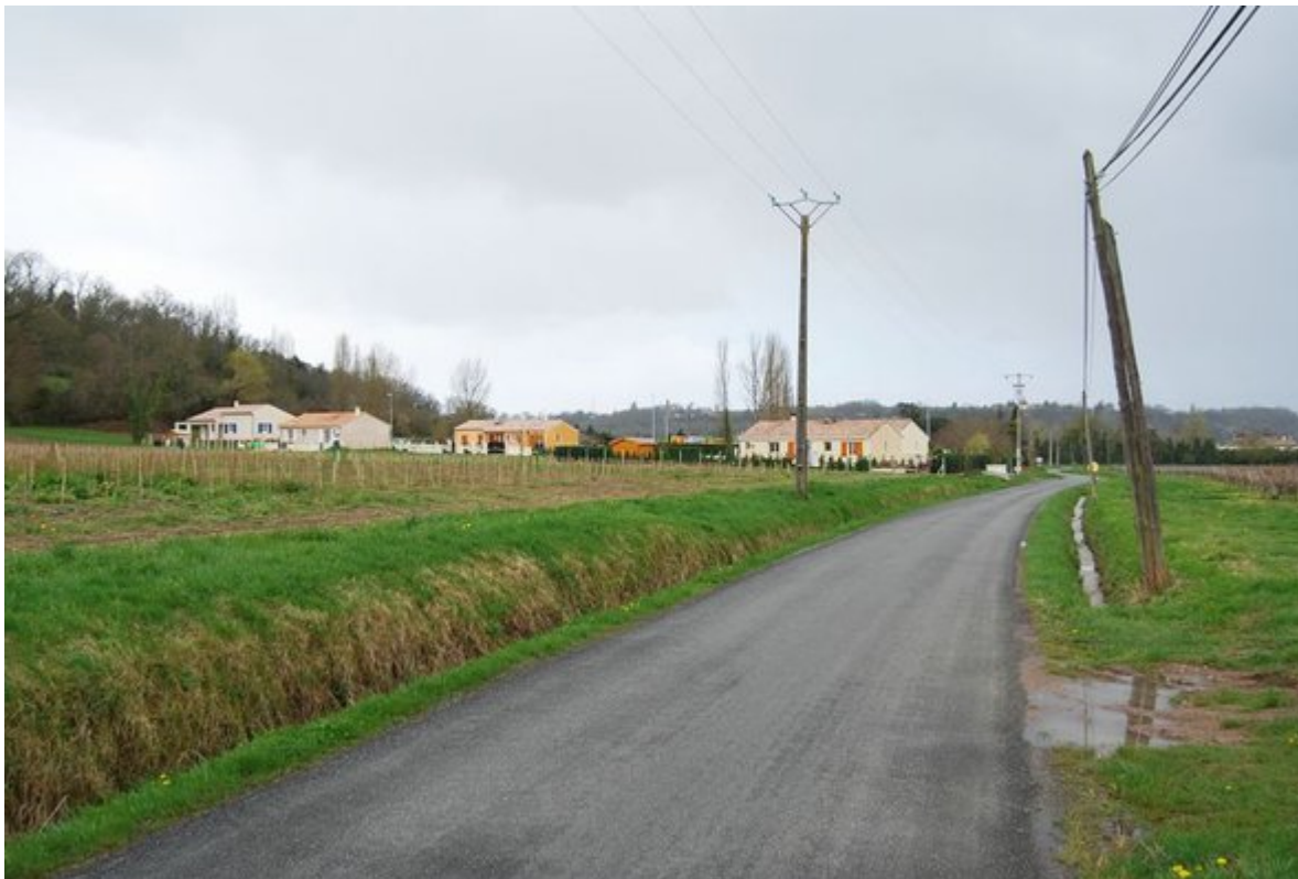
A l'est du bourg principal, quelques pavillons occupent d'anciennes terres viticoles en pied de coteau - Pessac-sur-Dordogne crédits : Agence Folléa-Gautier
