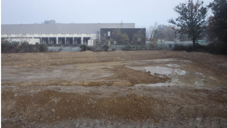
Figure 2 - Terrassements menés en zone Nord-Est
