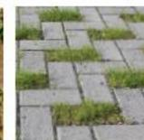
**Pavés à joints larges perméables** (pavés béton ou pierre)
