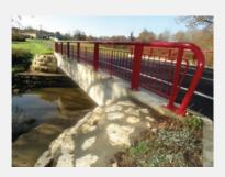
et un risque d'effondrement, aggravant la situation du pont. D'un montant de 430 000 euros, le chantier a intégré les futurs usages de cette route, avec une dalle en béton sur micro-pieux d'une largeur plus importante que précédemment. Aujourd'hui, pour le Département, moderniser et sécuriser le réseau routier c'est aussi faire face à l'évolution des pratiques des usagers, à la fréquentation en hausse, et répondre aux conditions climatiques.
