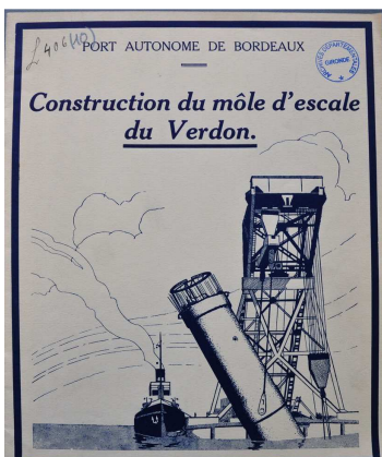
GAIN Louis. Construction du môle d'escale du Verdon. Extrait de La Technique des travaux , septembre 1931 Archives départementales de Gironde, BIB L 406
