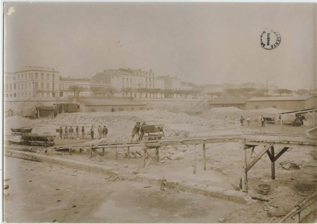
Photo du chantier de construction de la jetée-débarcadère pour le bac du Verdon, 1896 Archives départementales de Charente-Maritime, 1Fi Royan
